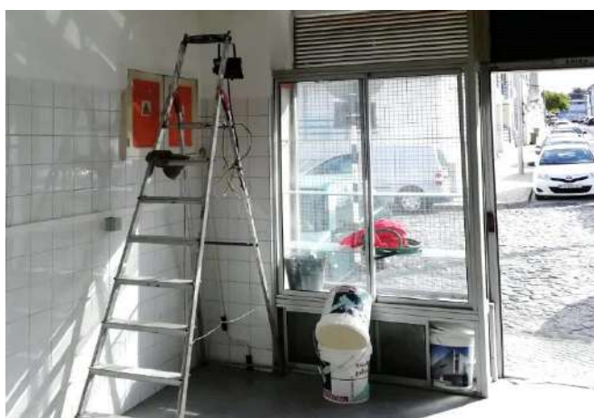
Reparação e pintura de loja no Mercado Municipal da Trafaria.
