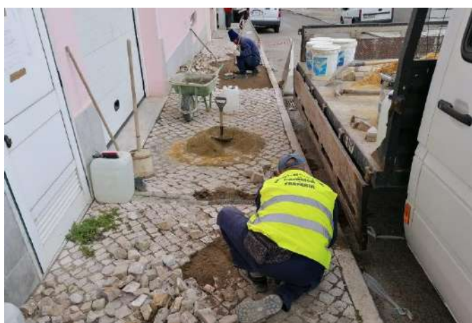
Reparação de calçadas e pinturas na Rua do Casalinho da Rosa.
