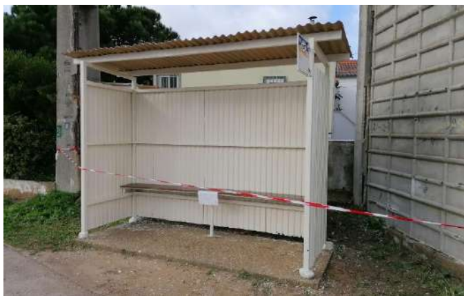
Pintura e substituição de telhas no abrigo da Cova Vapor.
