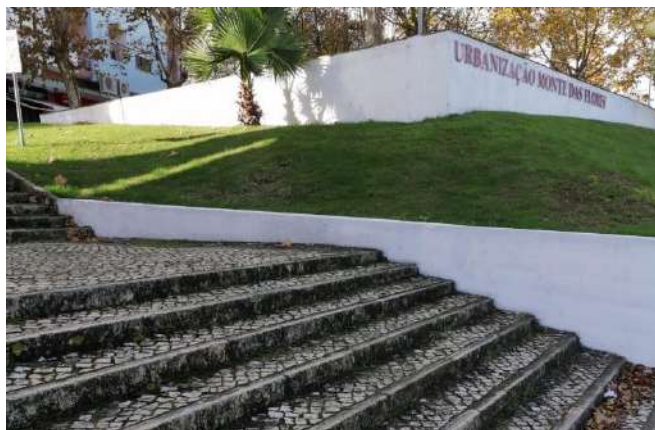
Pintura de muros na urbanização Monte de Flores, Caparica.
